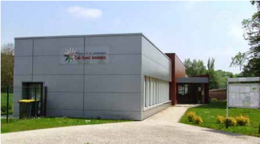
Les locaux pour la nouvelle communauté de communes CC2SO.
