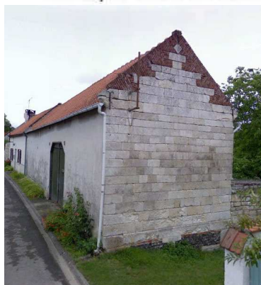
Deux types de pignons débordants En maçonnerie mixte de briques et pierres calcaires
