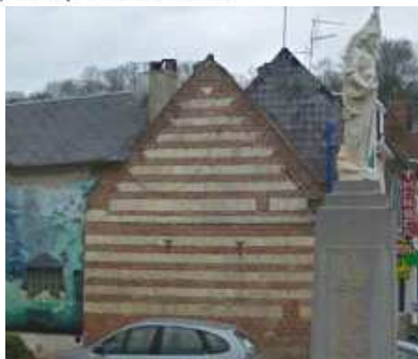
Deux types de pignons débordants En maçonnerie mixte de briques et pierres calcaires
